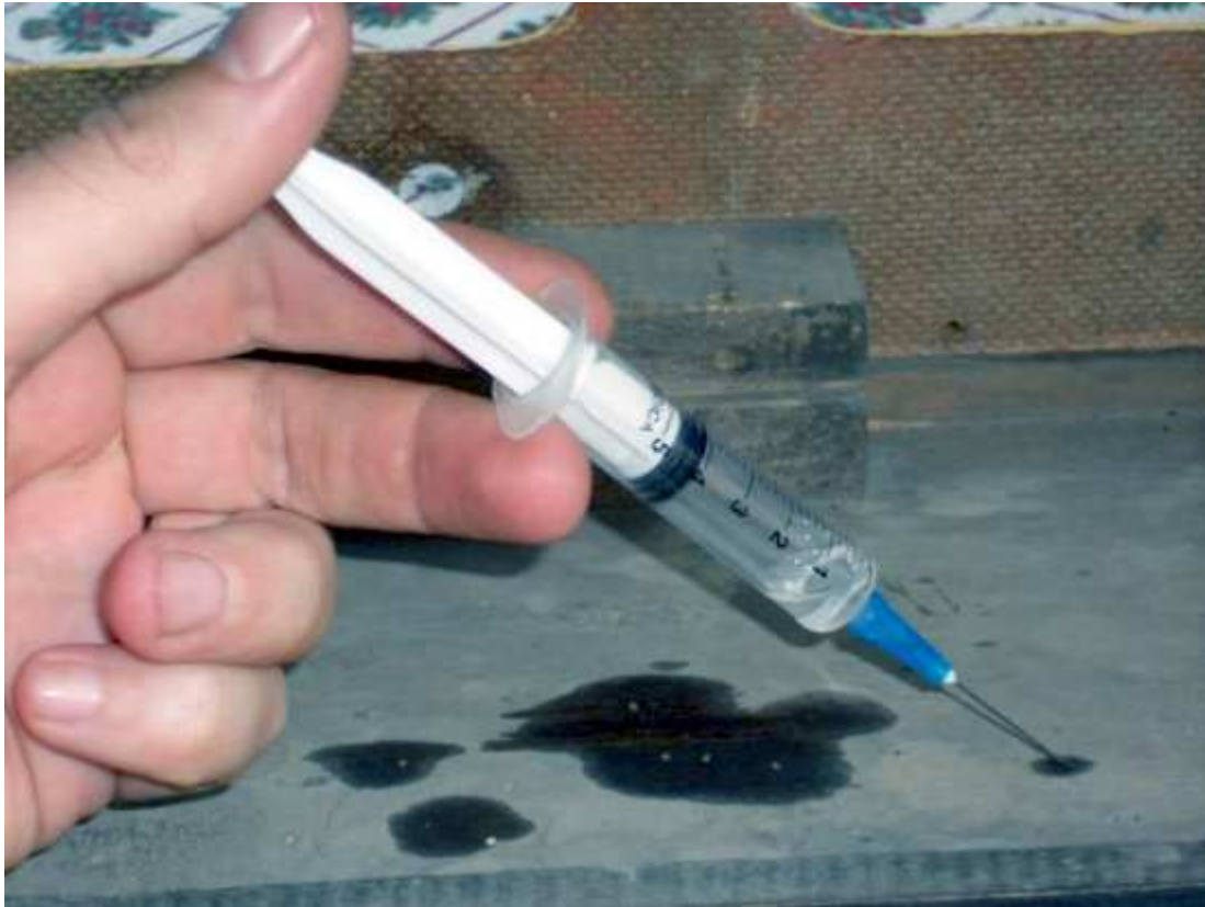
Fig 6: applicazione di prodotto antitarlo mediante riempimento delle gallerie.
